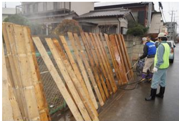
【はがした床板の洗浄】
