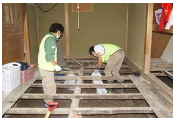
【床下の清掃作業】
