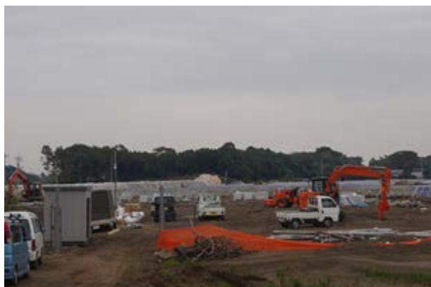
【越水現場での太陽光発電のパネルの撤】
