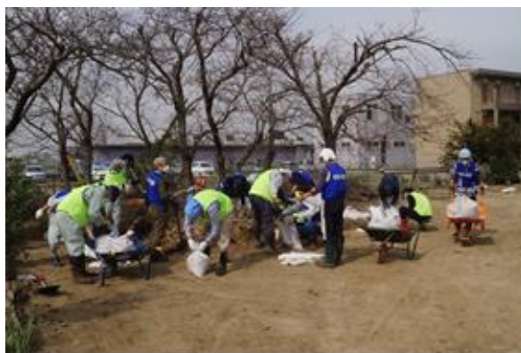
【庭に溜まった泥を撤去します】
