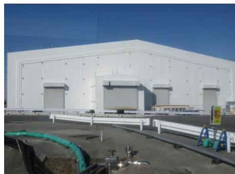
高性能多種核除去施設の外観
